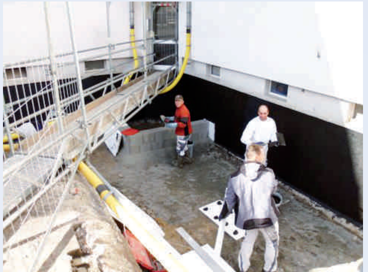
Die Fundamente werden vorbereitet
