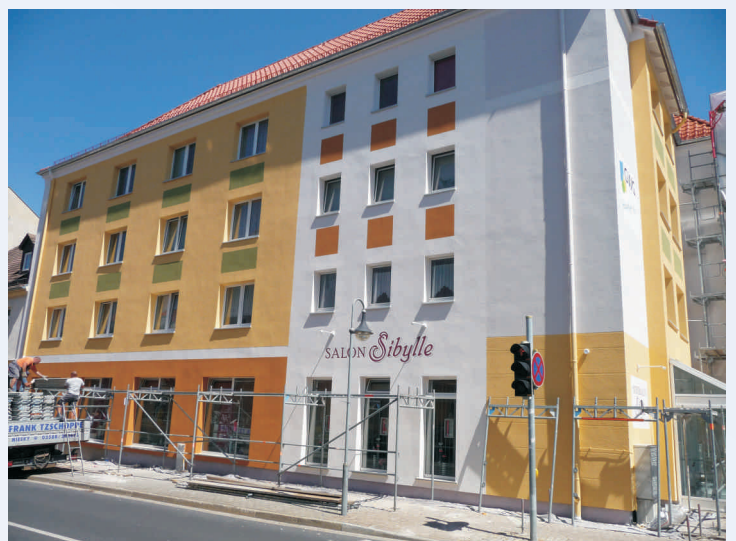
Die Fassade im neuen Glanz
